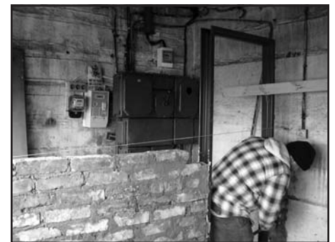
Rafal installing a door frame
